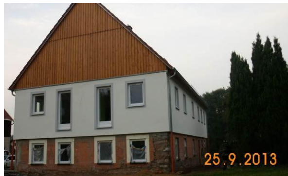
Wohnhaus im Vierseithof Erlbach-Kirchberg nach Wiederaufbau
