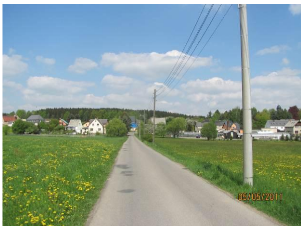
„Neue Straße“ vor Sanierung
