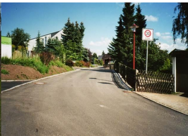
Plutostraße nach Sanierung
