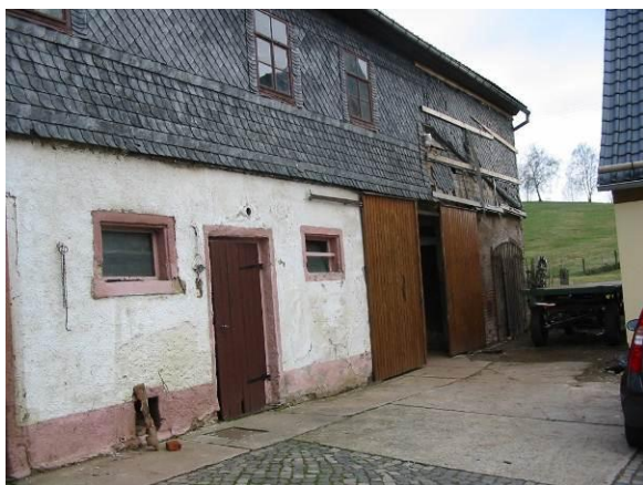
Scheunengebäude vor Umbau
