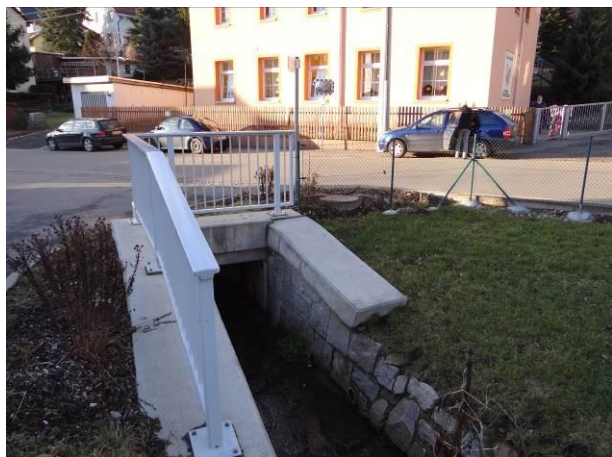
Durchlass am Kindergarten in Erlbach-Kirchberg
