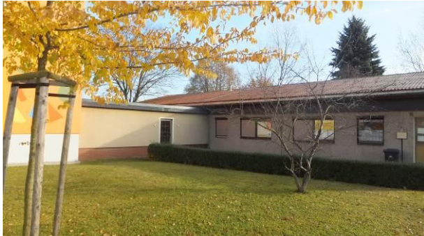
Kita und Vereinshaus Hohndorf vor Sanierung
