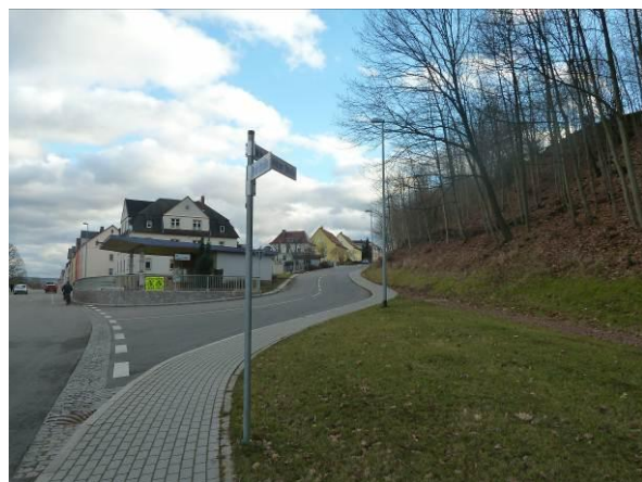
„Alte Oelsnitzer Straße“ nach Sanierung
