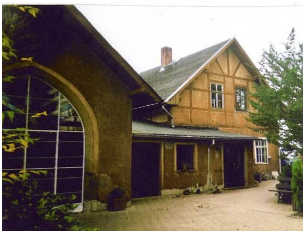
Friedhofshalle Hohndorf vor Sanierung
