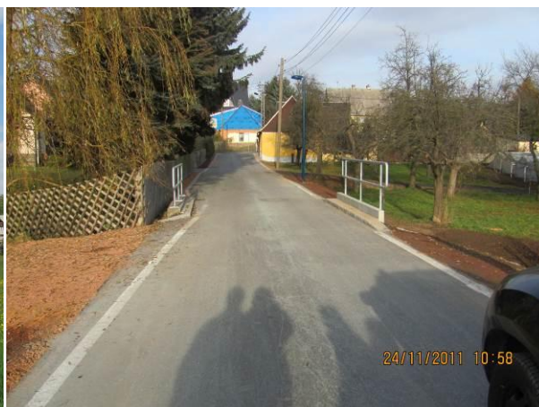
„Neue Straße“ nach Sanierung
